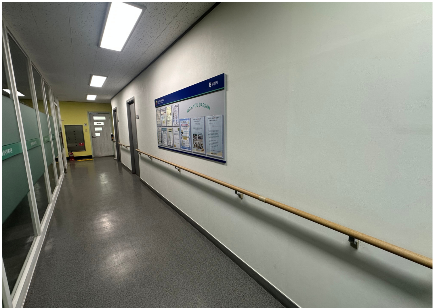
5층 전경 (천정 석면 철거 및 핸드레일 설치)
